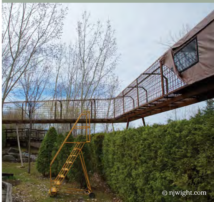
L'extension de la passerelle est presque terminée!
